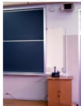
黒板の横にワイヤレスマイクアンテナとリモートコントロールパネルを設置
