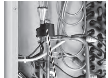
電子膨張弁コイル
