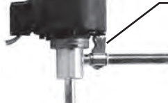
電子膨張弁入口パイプ
