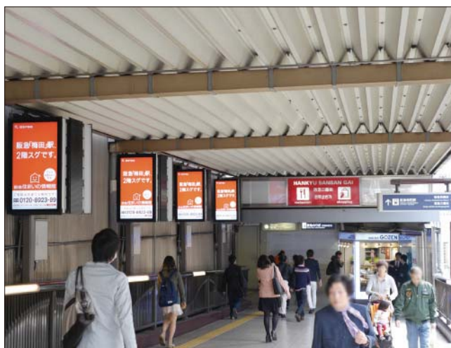
▲JR大阪駅との連絡通路に設けられた「2階連絡橋」は6台の防塵防水ディスプレイで構成。風雨が吹き込む半屋外環境でも高輝度な映像を安定して表示。
