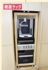
◀BDプレーヤー、書画カメラなどの映像ソースは、その他の映像機器とともにラックに設置。通常は講義室前方の壁に収納され、必要な時に扉を開いて使用。メンテナンス時には、引き出すことが可能。
